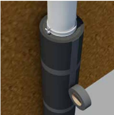
Beim Einsatz zur Tauwasserdämmung sind alle Nähte mit K-FLEX K420 Kleber zu verkleben. Stoßkanten und Überlappungsnaht mit geeignetem K-FLEX Klebeband abdecken.
