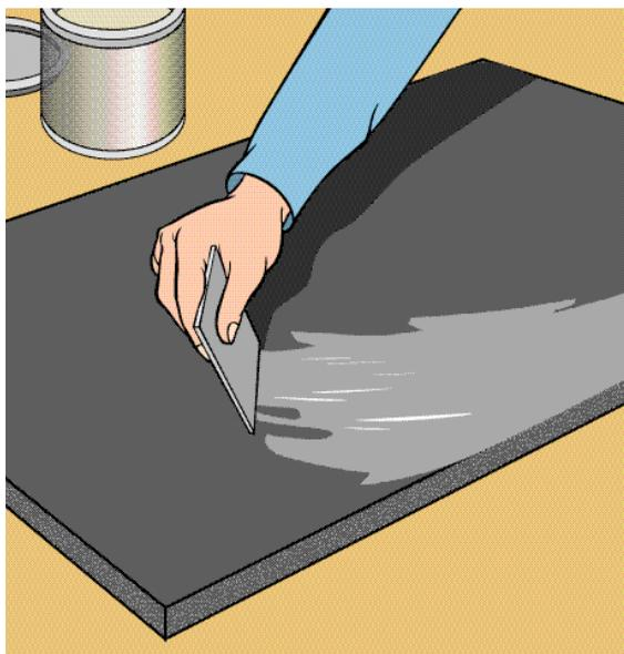
Zum Verteilen des Klebers auf große Flächen kann man einen Spachtel oder eine Lammfell-Rolle benutzen. Auch hier sollte der Kleber sparsam aufgetragen werden. Nach ausreichender Abluftzeit kann das Plattenmaterial auf die zu isolierende Fläche gebracht werden.
